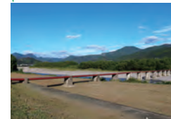
4 潜水橋(畑山橋)
